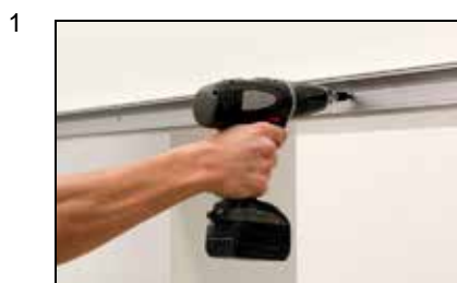
由正面將滑軌型材固定在牆上
