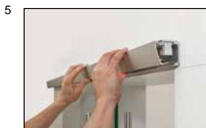
將外蓋押扣在塑膠扣件上
